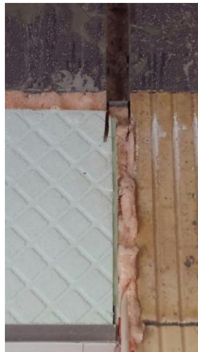
Schnitt in die Rollladendämmung
