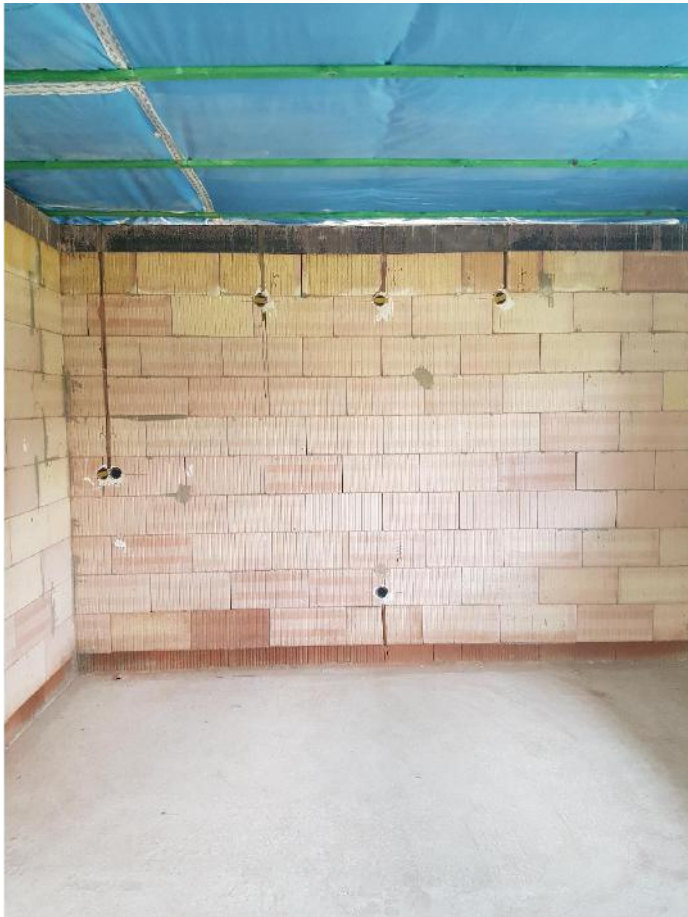
Deckendämmung
